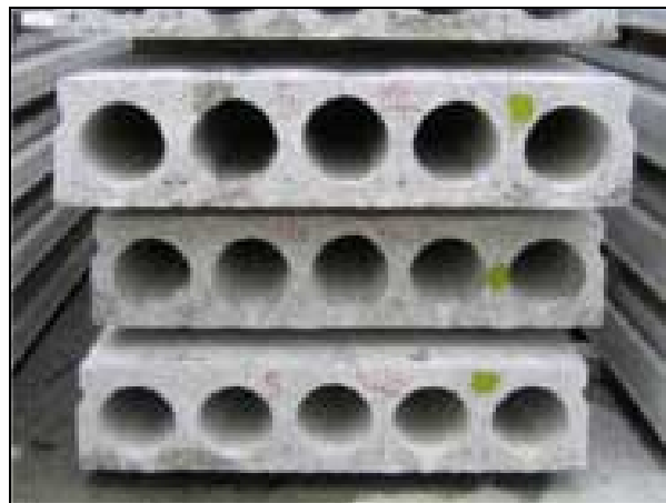
Figura 4. Tipiche sezioni di solai alveolari estrusi
